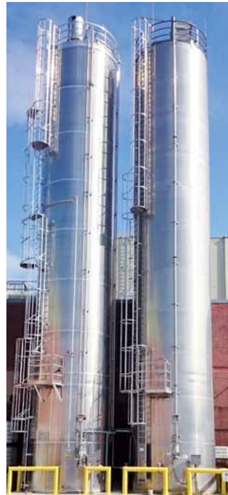
■ Aluminium-Silo 200 m 3 für schwerfließendes Zellulosepulver ■ Aluminium-silo 200 m 3 for bridging cellulose powder
